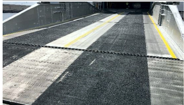
Rampa de acesso de veículos a Ferry LOCTITE PC 6315 & 6261
