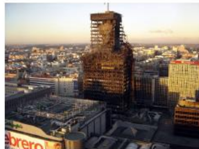
Torre Windsor, Madrid 12 Fevereiro 2005
