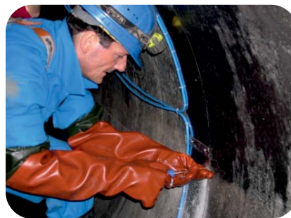
Montagem do equipamento por pessoal técnico especializado.
