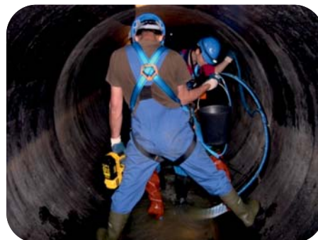
Remoção do equipamento após utilização sem alterações da operacionalidade do colector
